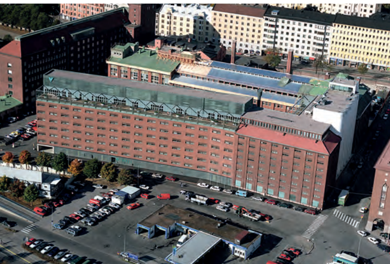
Valtakunnansyyttäjänvirasto muutti Helsingin Lintulahteen 27.2.2017. Viraston tilat remontoitiin oikeusministeriön toimitalakonseptin mukaiseksi monitilaympäristöksi. Kuva Senaatti, Suomen Ilmakuva Oy
